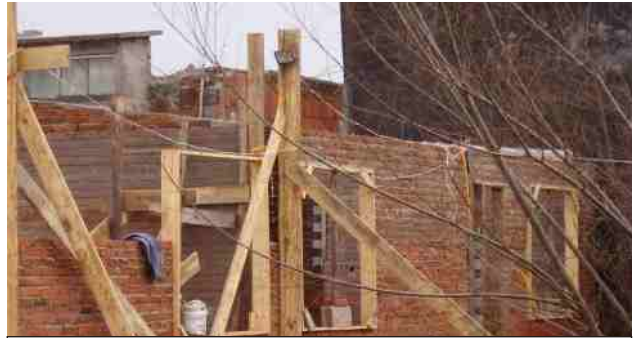
Construcción de tres casas de dos ambientes, a cargo de la AUOM
