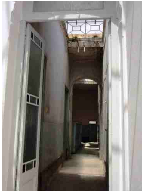
Foto: pasillo del 1er piso.
